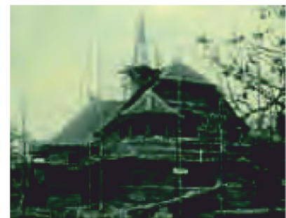
Die reformierte Kirche im Bau vor 100 Jahren
